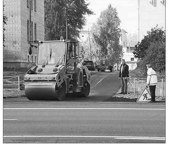
■ Подъезд к больнице № 4
